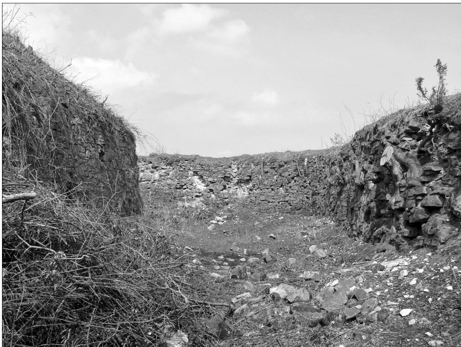
Velká šance. Příkop v severovýchodní části opevnění s dochovaným kamenným armováním vnitřní (eskarpy) a vnější (kontreskarpy) stěny příkopu. Na postupné destrukci se významnou měrou podílí kořeny stromů, r. 2008.
