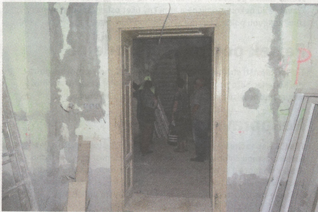
Práce uvnitř Knížecího domu jsou v plném proudu.
