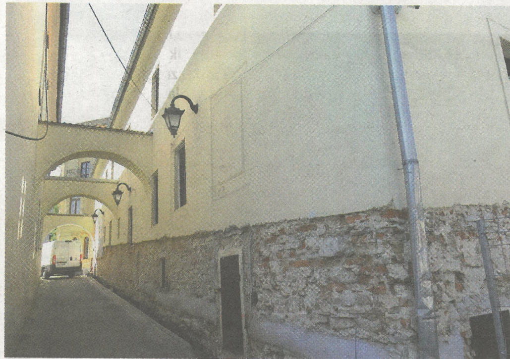
Během opravy střechy a fasády bude ulička neprůjezdná.
