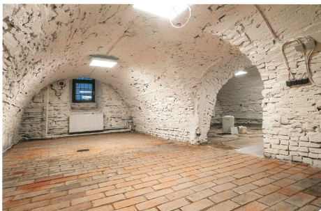
Wyremontowane pomieszczenia piwniczne (Milan Baránek, Muzeum Těšínska)
