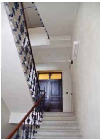
Schodiště jsou po opravě k nepoznání.
