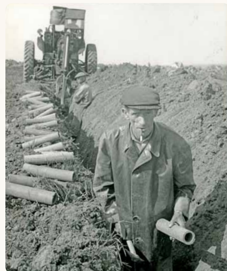
Meliorační práce na pozemcích jednotného zemědělského družstva v Mostech u Českého Těšína, květen 1960
