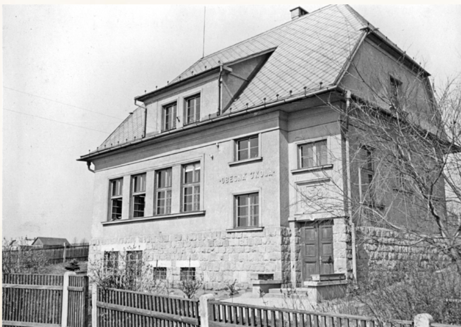
Objekt české obecné školy v Koňákově postavený stavební firmou Jakuba Stejskala a Jindřicha Drábka ze Slezské Ostravy v roce 1926, 30. léta 20. století (Státní okresní archiv Frýdek-Místek)
