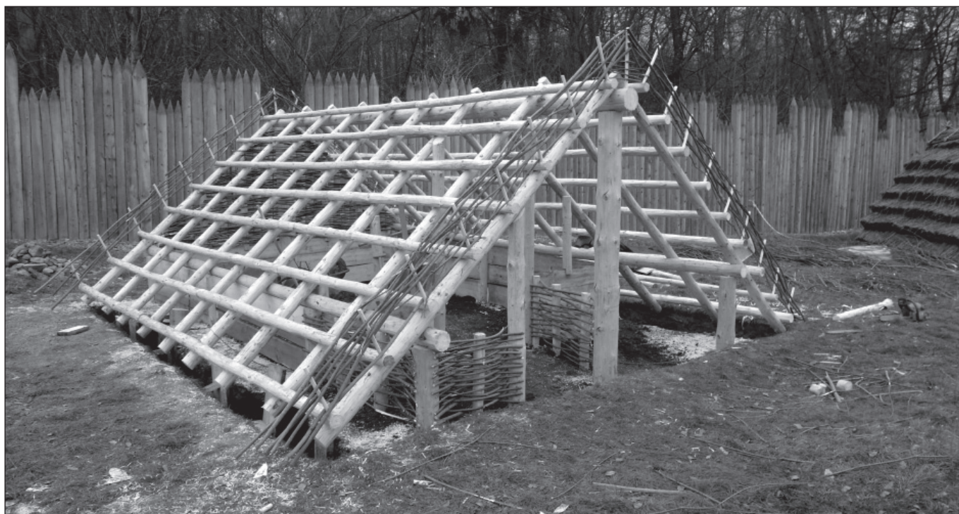
Výstavba nové zemnice v Archeoparku, 24. listopadu 2011, foto Ondřej Tůma
