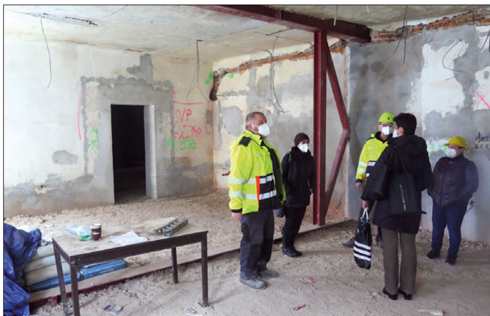
Při rekonstrukci Knížecího domu v Jablunkově probíhaly časté a pravidelné kontrolní dny na stavbě za účasti zástupců investora, tedy Moravskoslezského kraje, i uživatele objektu – Muzea Těšínska. Na snímku účastníci kontrolního dne v budoucí výstavní síni v prvním patře. Zleva stavbyvedoucí Jiří Samek (BYSTRON Group a.s.), projektantka Zuzana Sýkorová (PROJEKTSTUDIO EUCZ, s.r.o.), projektový manažer Jaromír Satke (BYSTRON Group a.s.), investiční referentka Simona Kamrádová (Moravskoslezský kraj) a vedoucí provozního útvaru Naděžda Antalová (Muzeum Těšínska), 14. dubna 2021, foto David Pindur
