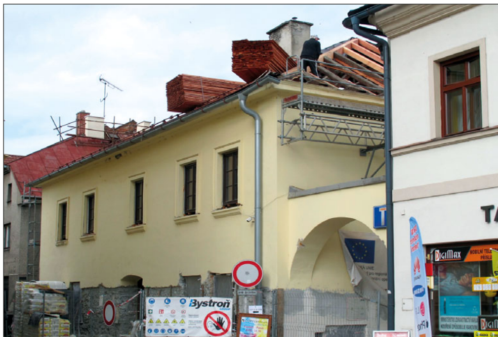
Po celý rok 2021 probíhala náročná rekonstrukce Knížecího domu v Jablunkově a jeho adaptace na budoucí Muzeum trojmezí. Z průběhu stavebních prací na střeše, 25. srpna 2021, foto David Pindur
